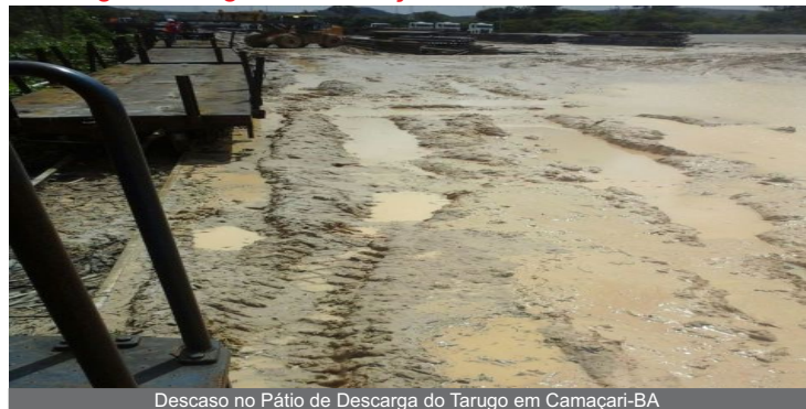
Descaso no Pátio de Descarga do Tarugo em Camaçari-BA
